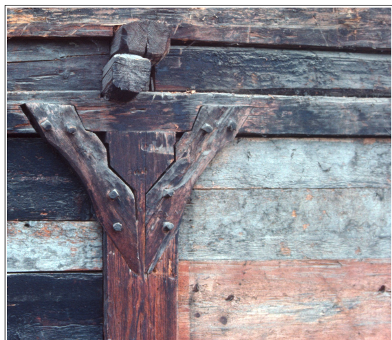
Abb. 2: Haus Kirchgasse 13 (nach 1468d) in Baar/ZG. Ständer und Bundrähm sind mit Kopfhölzern fixiert. (Foto: Franz Wicki, Amt für Denkmalpflege und Archäologie des Kantons Zug)
