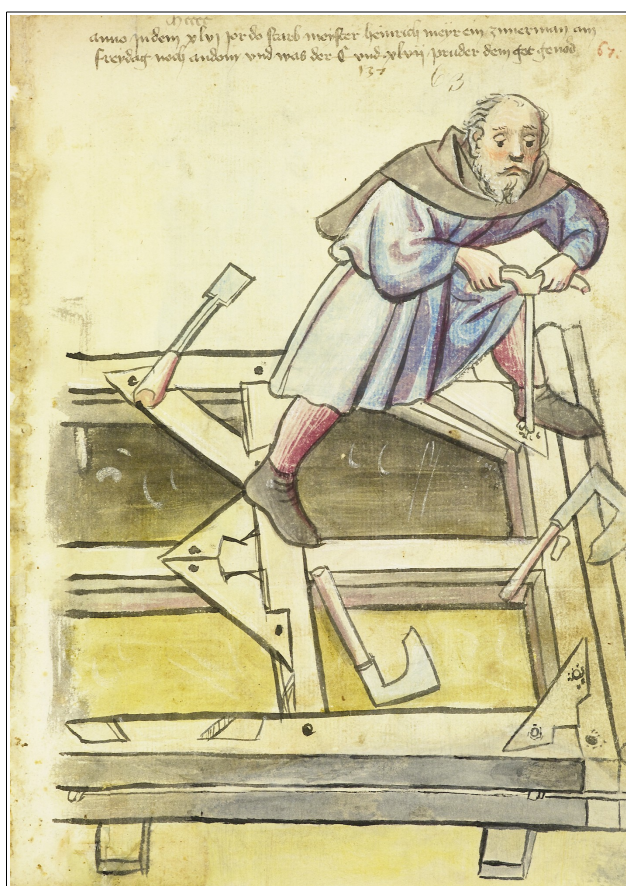
Abb. 3: Die Kopfhölzer werden an den liegenden Bundfluchten montiert. Hausbuch der Mendelschen Zwölfbrüderstiftung, kolorierte Federzeichnung, 1446, Stadtbibliothek Nürnberg, Amb. 317.2°, fol. 67r.
